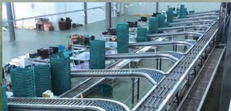
华润江苏医药新建物流仓库
